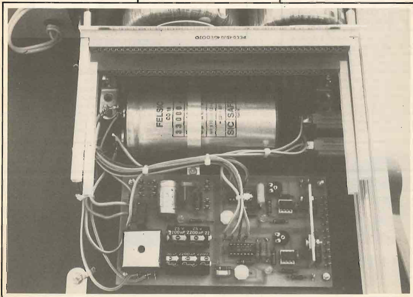
Le câblage de l'alimentation est terminé.
